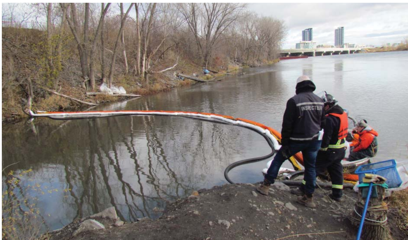
Inspection et nettoyage des berges
